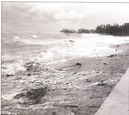
La fuerte marejada que recibe a diario la costa de Rincón ha causado el derrumbe de un muro en el balneario.
