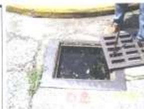
Sector: Puerta de Tierra - Calle San Andrés - esq. entrada a Residencial Puerta Tierra
