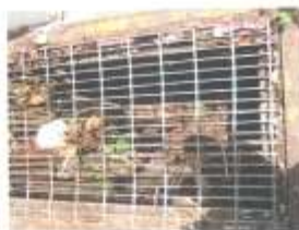
Sector Puerta de Tierra-Calle No 5 esq. Ava. Ponce De Leon
