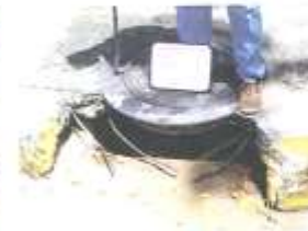
Sector Condado- Int. Calle Eastley y Calle McHenry
