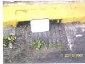
Sector Miramar – Int. Ponce de Leon y Calle Fernández Campo
