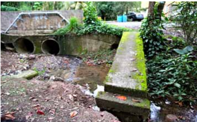
Una quebrada corriendo por debajo de una calle en Caimito.
