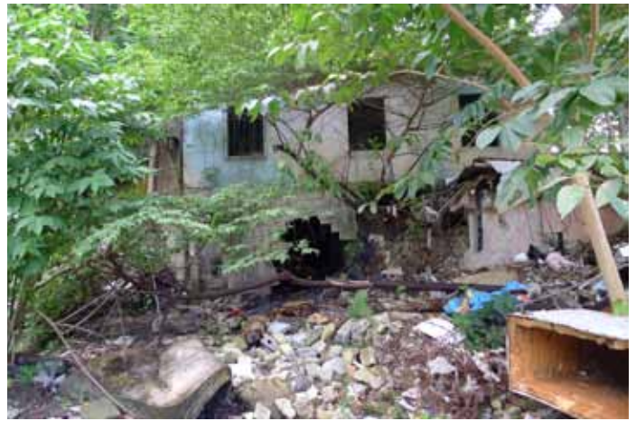
Pequeña quebrada bajo estructura en Capetillo: Por años la falta de conciencia provocó patrones de usos del suelo que ponen en peligro la vida de las personas.
